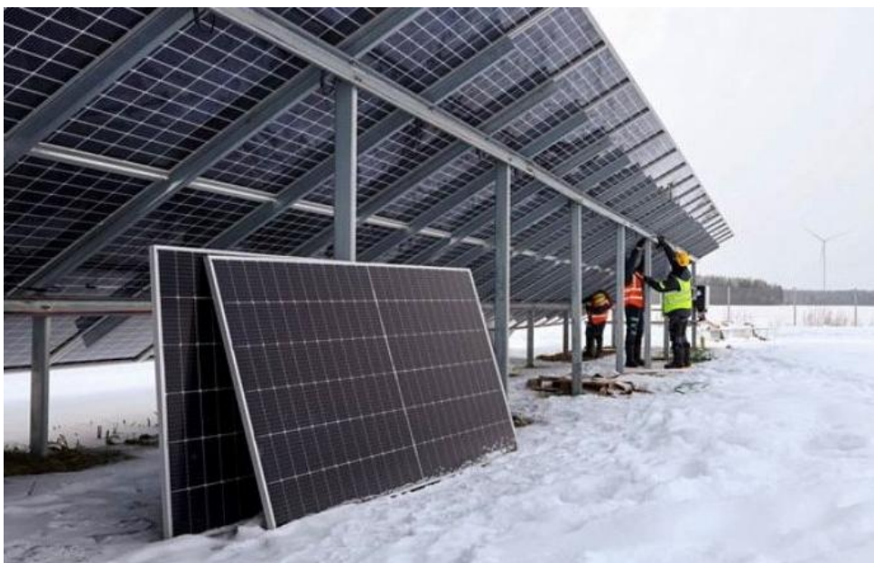
Kuva 6. Paneelit asennetaan 30 asteen kulmaan (kuva Helsingin Sanomat)
