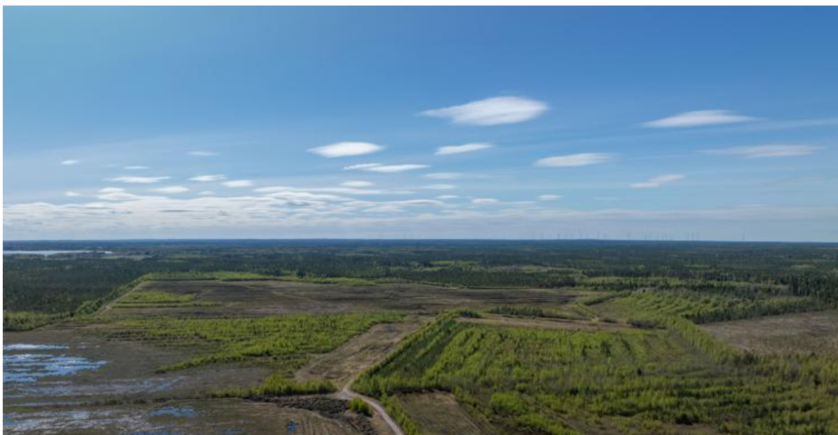
Kuva 28. Kuva hankealueelle 100 m korkeudesta Kivinevantien suunnasta
